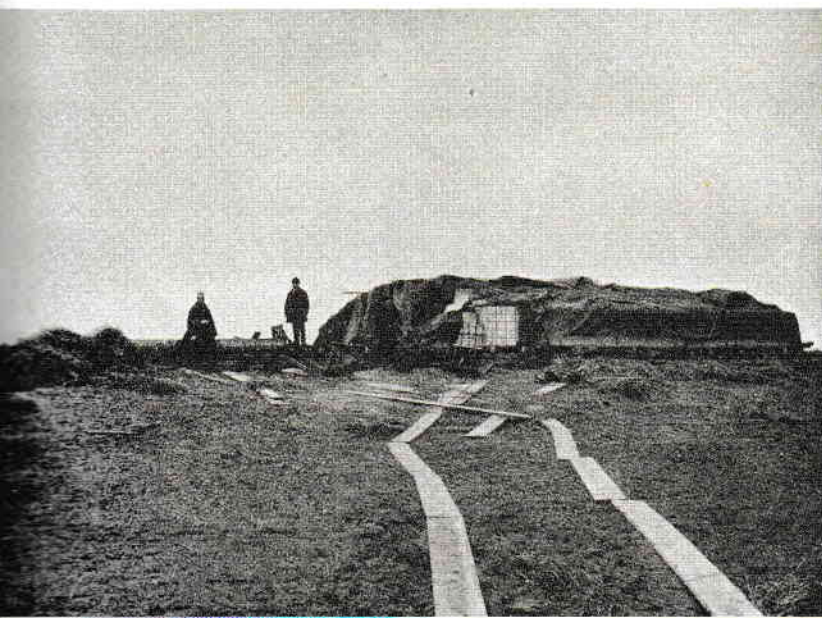
De gehavende loods op de Schürpoll daags na de ramp. De wanden en dak zijn door de explosie compleet weggeblazen. Wat rest, zijn de niet ontplofte dynamiekisten onder dekzeilen. (Foto R. Velsink, collectie KB | Nationale bibliotheek)
