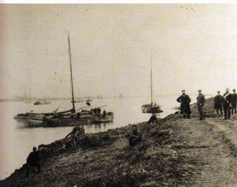
Bovenste foto: De Vier Gebroeders (voor) en de Maria Odelia enkele dagen na de ramp. Op de foto daaronder is op de achtergrond ook de Gesina zichtbaar. (Collectie Heemkundekring Rijnwaarden)
